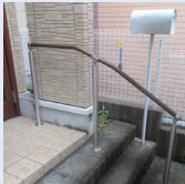
屋外階段手すりの施工事例 ▲
