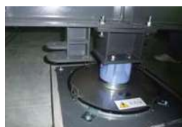
ボース支承 （スライド機構・変位復元機構）
