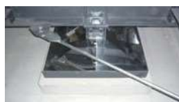
滑り支承（スライド機構・減衰機構）
